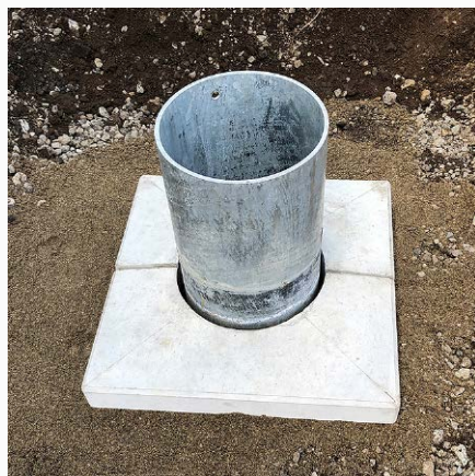
3 Gブロックを設置。
