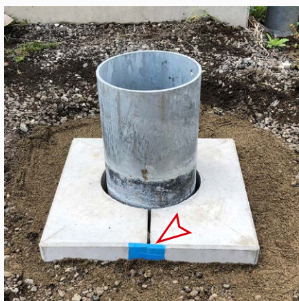
4 テープで端部をモルタル漏れ止め。
