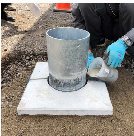
5 無収縮モルタルを注入。
