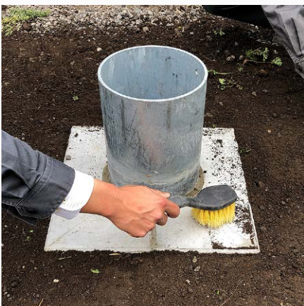
8 周辺を突き固め、清掃。
