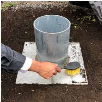
8 周辺を突き固め、清掃。
