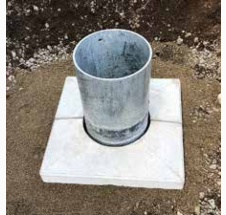
3 Gブロックを設置。
