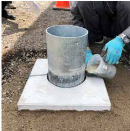
5 無収縮モルタルを注入。
