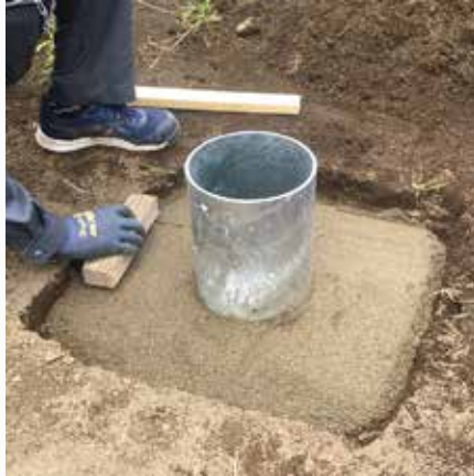
2 砂を敷き、均す。
