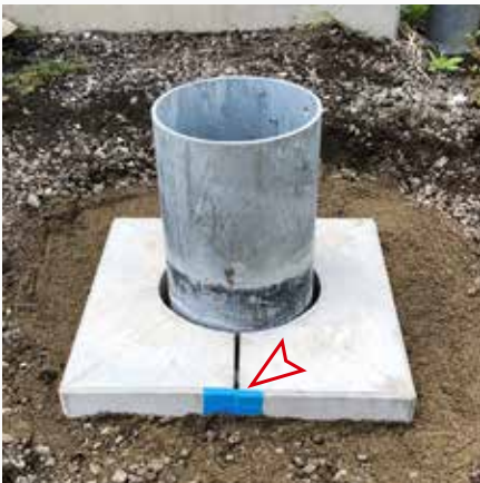
4 テープで端部をモルタル漏れ止め。
