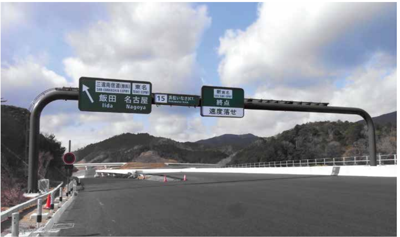
門型標識柱 (NEXCO中日本)
