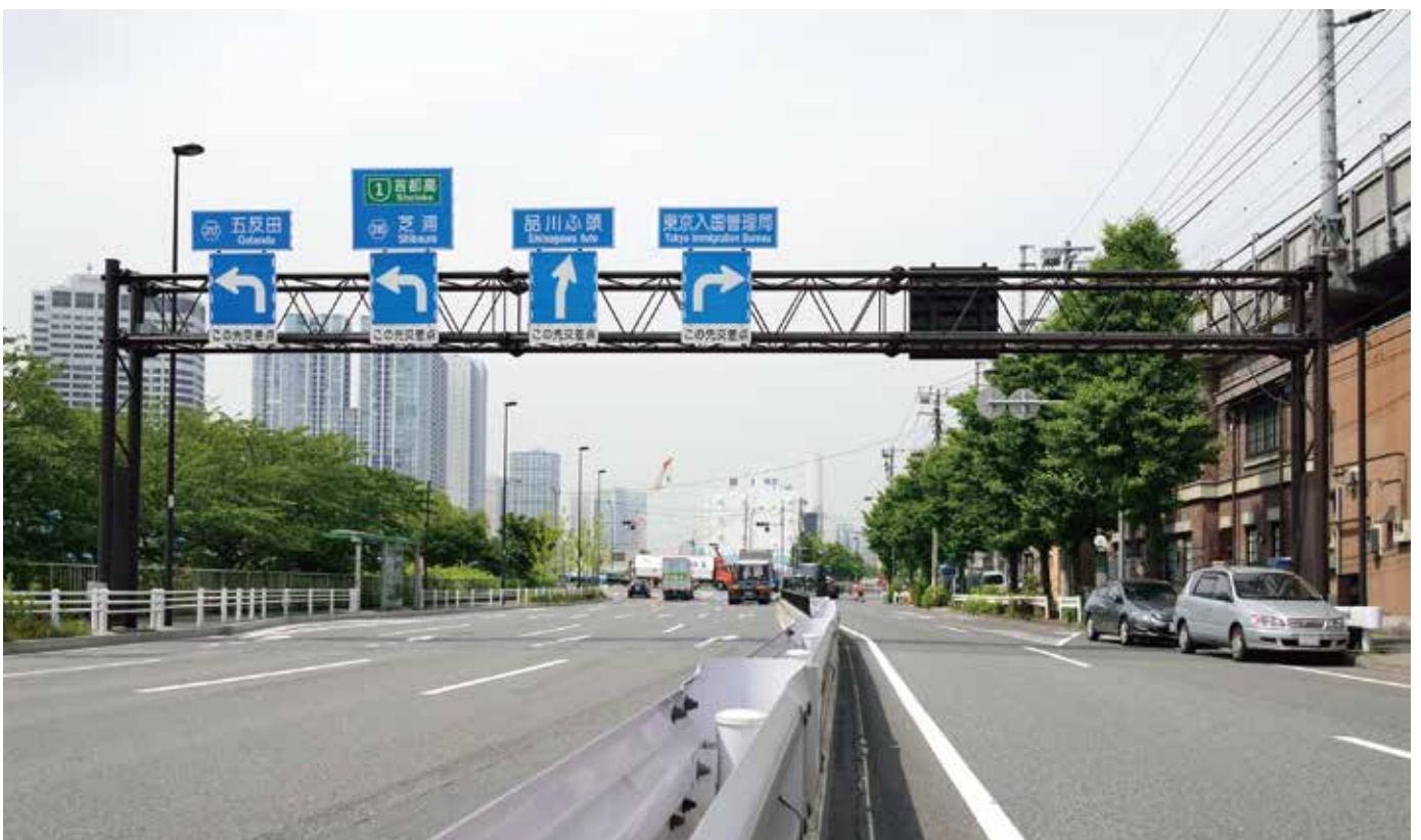
トラス門型標識柱
