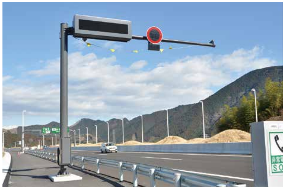
CCTV集合柱（NEXCO中日本）
