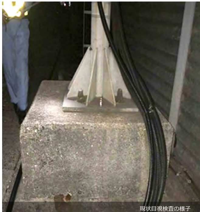
現状目視検査の様子
