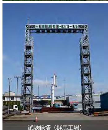
試験鉄塔（群馬工場）
