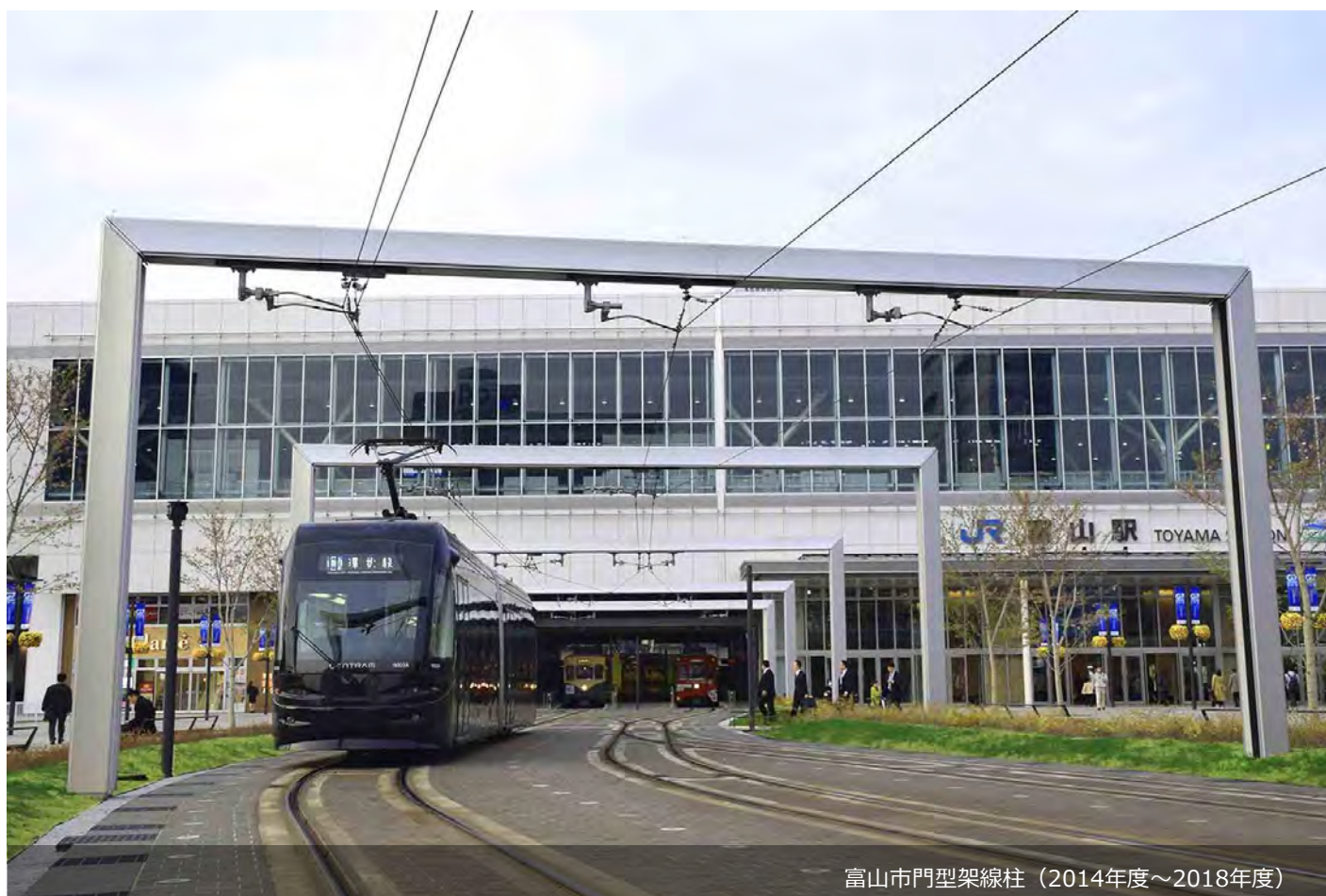
東京都交通局様 東京さくらトラム架線柱（2017年度）
