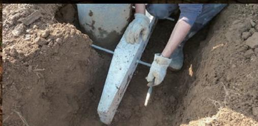
地際のポールには防食性に優れたコンクリート台柱を採用して長寿命化を図り、同時に根柢施工によって基礎打設を省略します。
