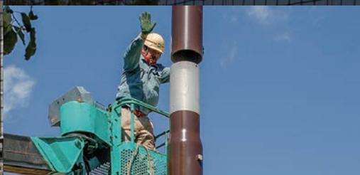
ポールの施工はスリップジョイントによる差込みの接合なのでボルト締付等の手間がありません。
