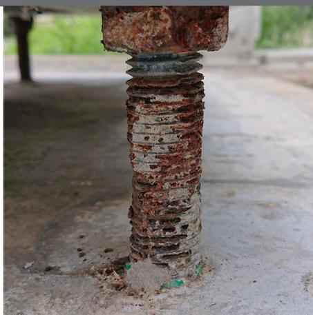
アンカーボルトの腐食が進行し、ボルトが破断するとポールが倒壊する恐れがあります。
