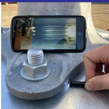
点検スペースを設けることでアンカーボルトの腐食状況を容易に確認できます。
