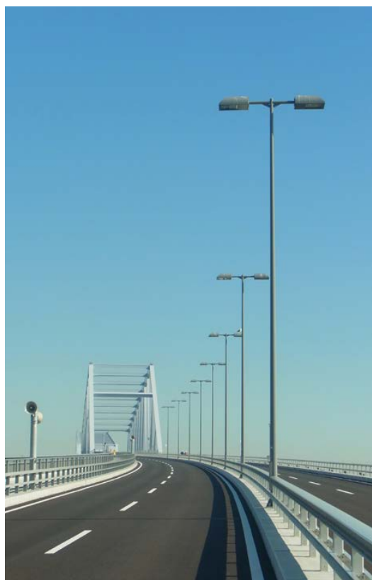
東京ゲートブリッジ
