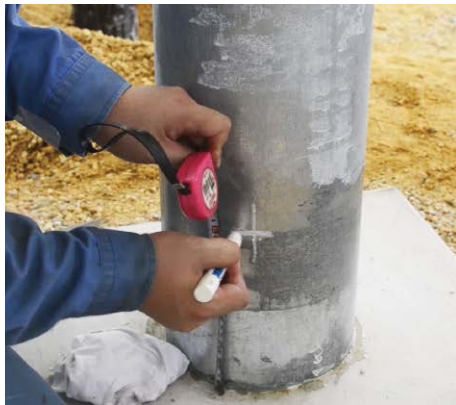
GL 上 150 ~ 200mm 位置に原点をマーキングします。
