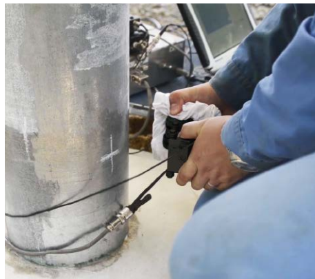
自走式センサーを取外し、調査完了です。
