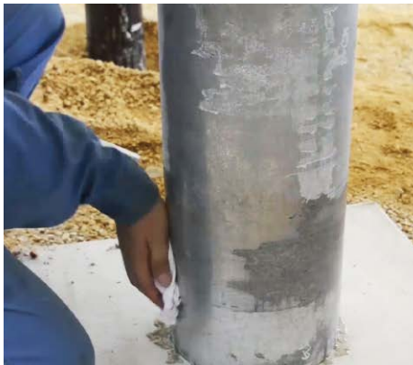
ウエスで鋼管表面の汚れを拭き取ります。
