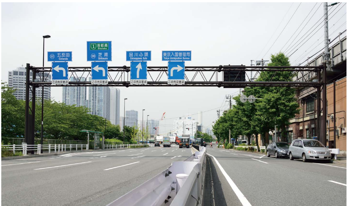
トラス門型標識柱
