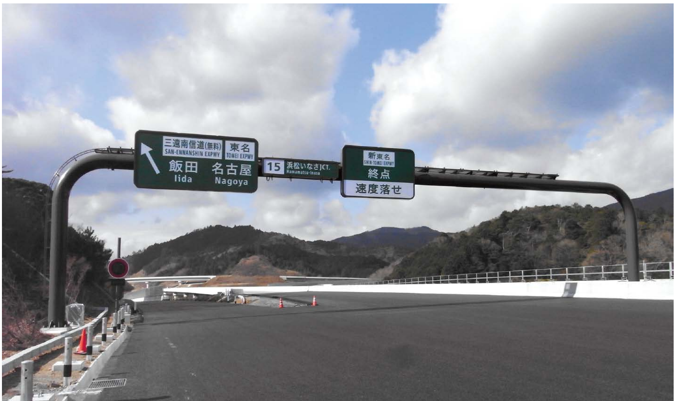
門型標識柱（NEXCO中日本）
